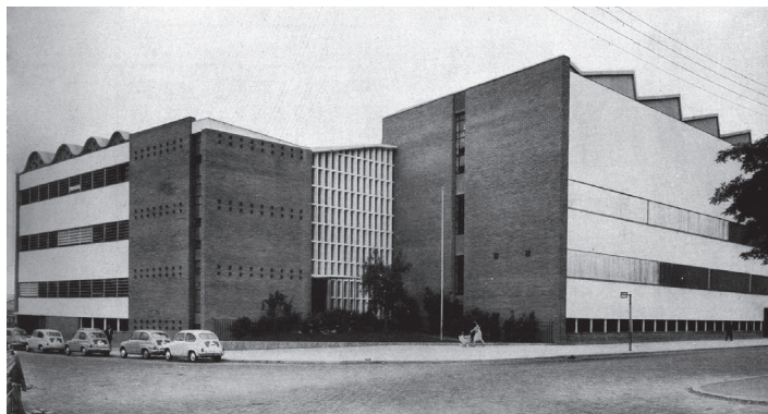
FIG. 1 Escuela de aprendices para empleados de la SEAT en Barcelona. Autor desconocido. Fuente: Cuadernos de Arquitectura , Barcelona, nº 35, 1959, p 15. Apprentices' school for SEAT's employees in Barcelona. Unknown author. Source: Cuadernos de Arquitectura , Barcelona, nº 35, 1959, p 15.
